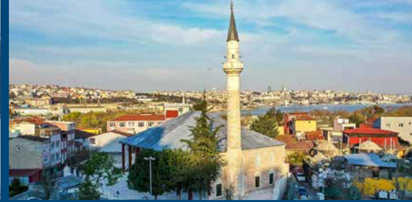
Restorasyon tamamlandıktan sonra caminin ve avlusunun genel görünüşü
