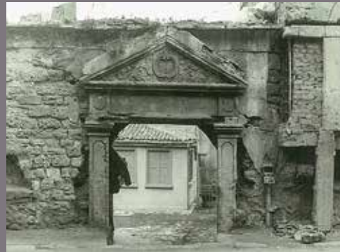
Şekil 6. Eski bir fotoğrafta avlu giriş kapısının görünüşü (Çiğdem Karamanoğlu'ndan).
