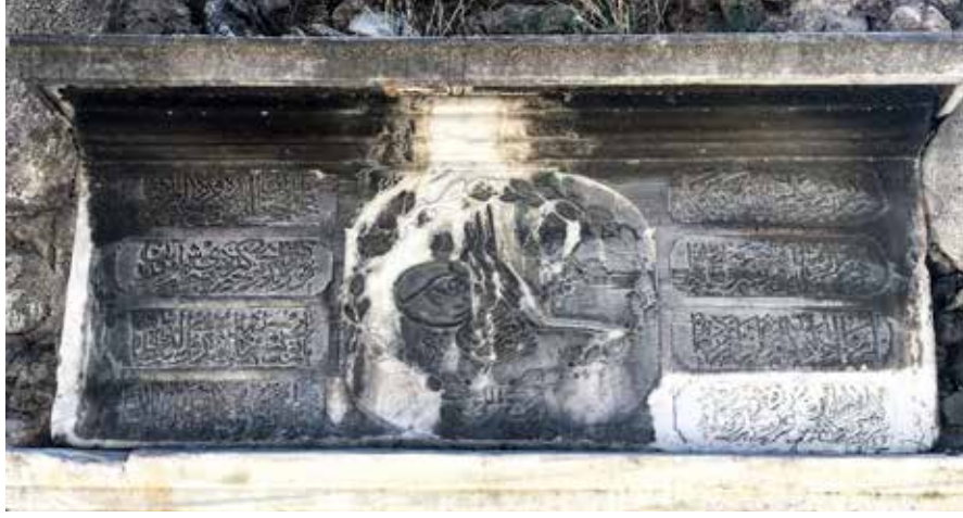
ŞEBİNKARAHİSAR PERTEVNİYAL VALİDE SULTAN ÇEŞMESİ (1865) Kesme taş malzemeden inşa edilen çeşme dikdörtgen planlıdır. Sivri kemeri üzerinde on satırlık kitabeye sahiptir. Günümüzde işlevini devam ettirmektedir.
