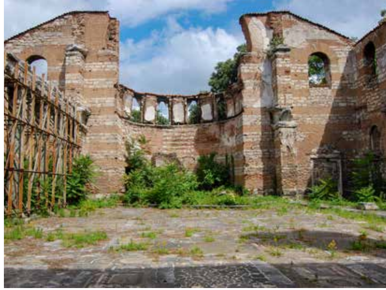
Yapı içinden mihraba doğru bakış
