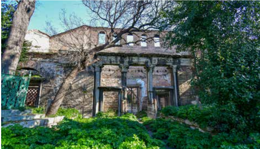
Yapının batı cephesinden görünüşü
