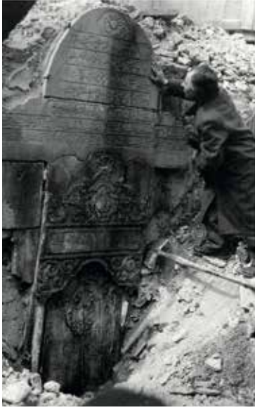
Revnakoğlu, Hatice Sultan Çeşmesi yıkılmadan hemen önce tespit hâlinde
